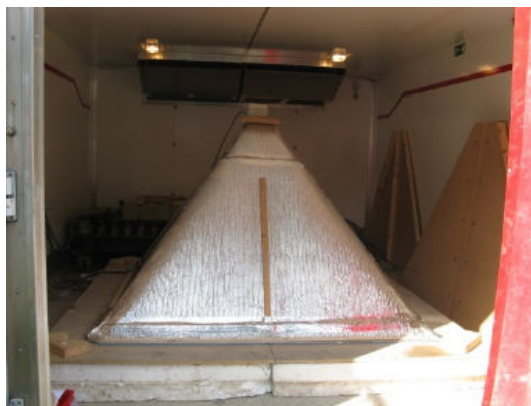
Zdjęcie 2 Izolacja Aluthermo Quattro® położona na krokwiach
