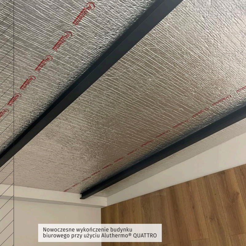
Profesjonalnie wykonany montaż docieplenia poddasza izolacją Aluthermo® QUATTRO w remontowanym pomieszczeniu biurowym
